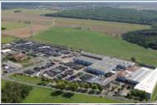
Planta de producción en Dachstein (Francia)
