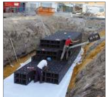
Edificio industrial, Neu-Ulm (Alemania)
