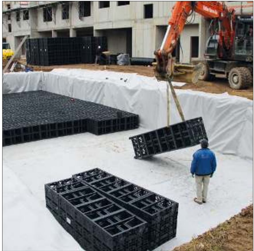
Edificio industrial, Friburgo (Alemania)
